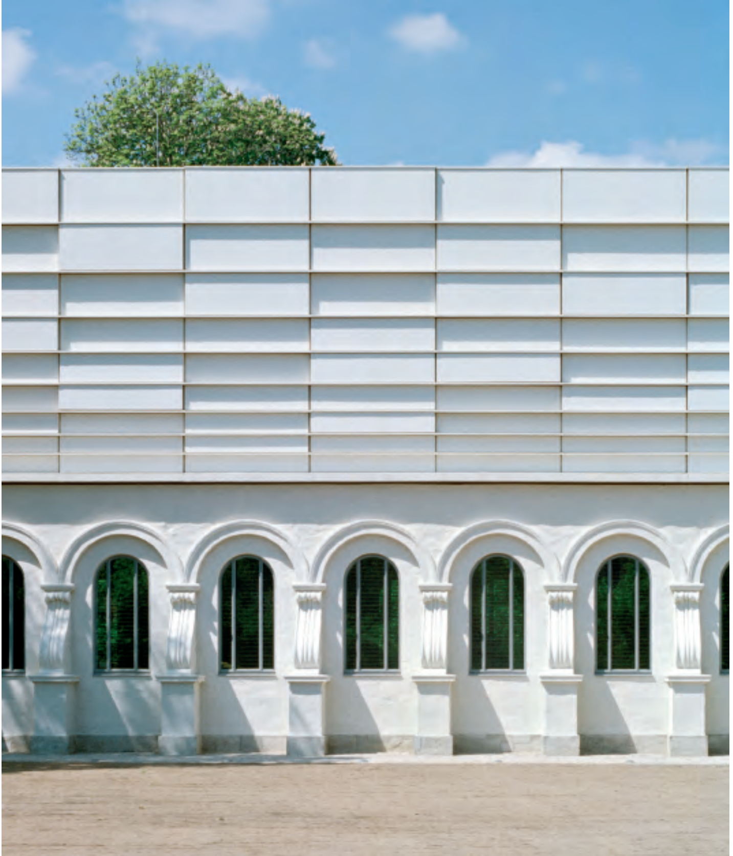
Johann-Sebastian-Bach-Saal, Köthen Deutscher Fassadenpreis für vorgehängte hinterlüftete Fassaden 2009 Architekten: Busmann und Haberer, Berlin Produkt: Eternit Fassadentafeln EQUITONE [natura] Foto: Werner Huthmacher, Berlin
