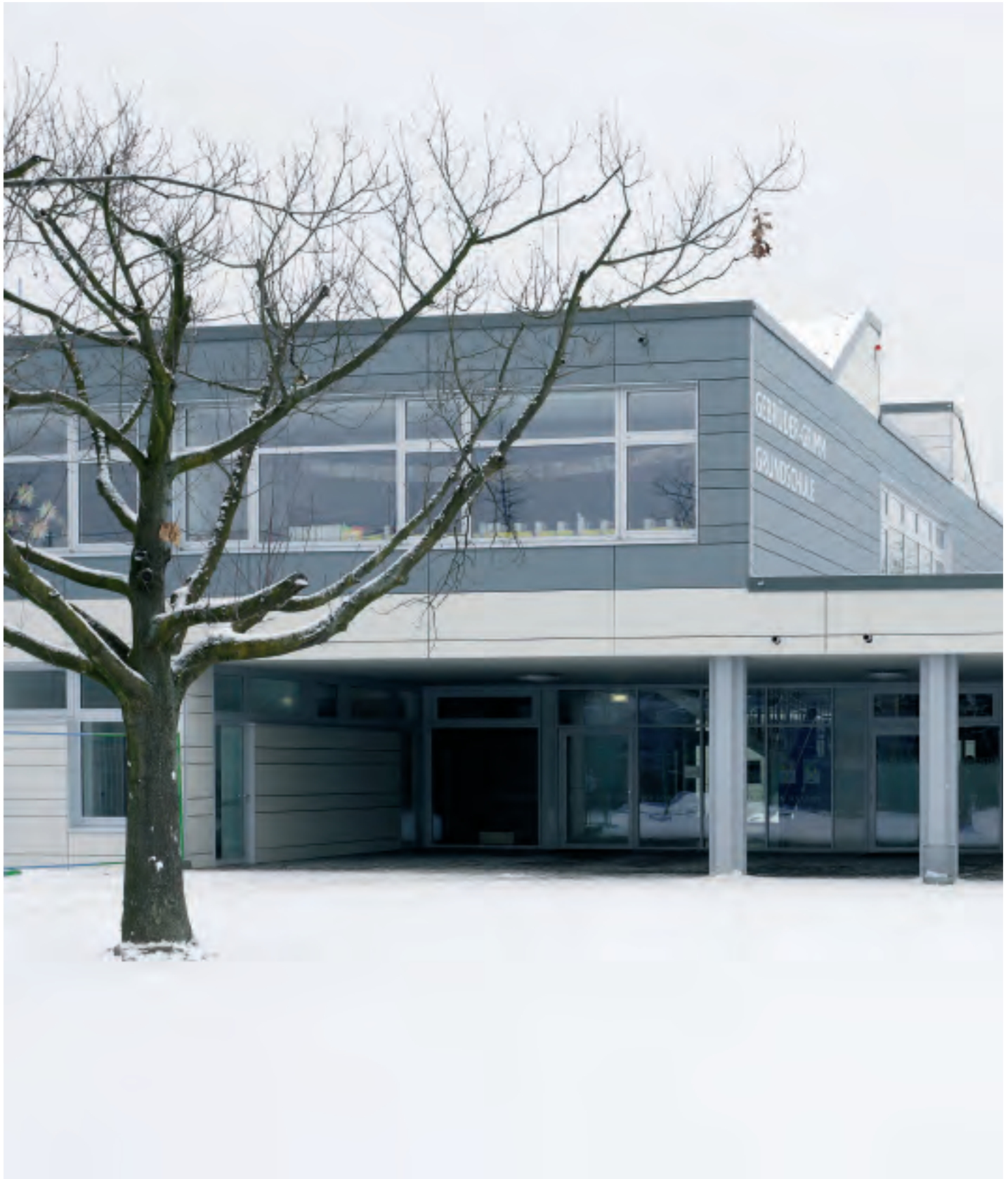
Gebrüder-Grimm-Schule, Neuss Architekten: BM+P Architekten, Düsseldorf Produkt: Eternit Fassadentafeln EQUITONE [natura pro] Foto: Tom Reindel, Düsseldorf
